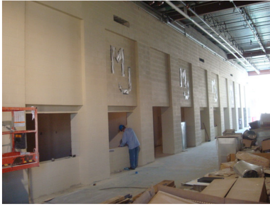
Lobby 2104 – Block Fill
